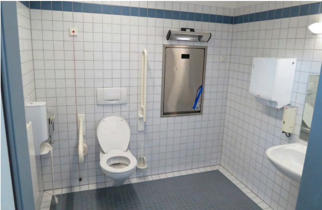
Abbildung 11: Beispiel für eine barrierefreie Toilette
