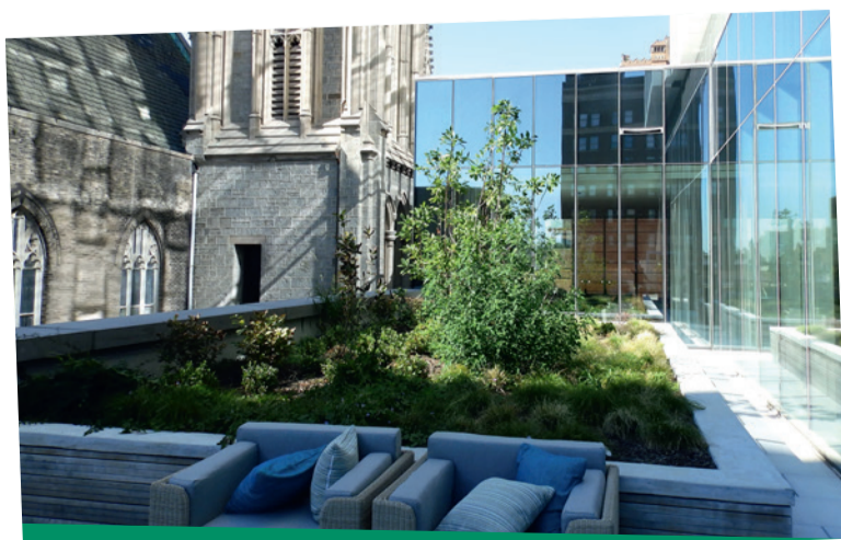
Podiumdeck eines mehrgeschossigen Gebäudes mit Dachgarten. Foto: Köhler
